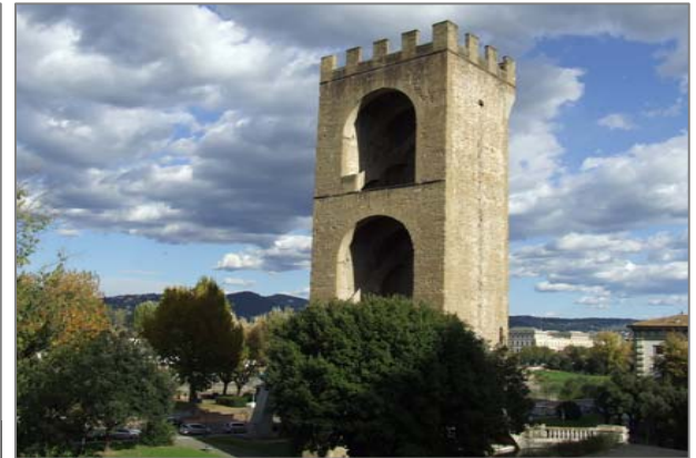
Porta di San Niccolò (Gate)
