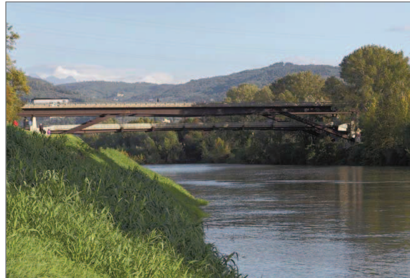
Veduta del Ponte di Varlungo
