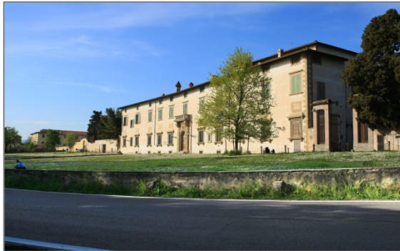
The façade of Villa Reale di Castello
