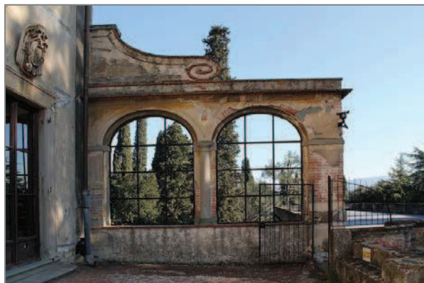
Villa di Rusciano, particolare della terrazza
