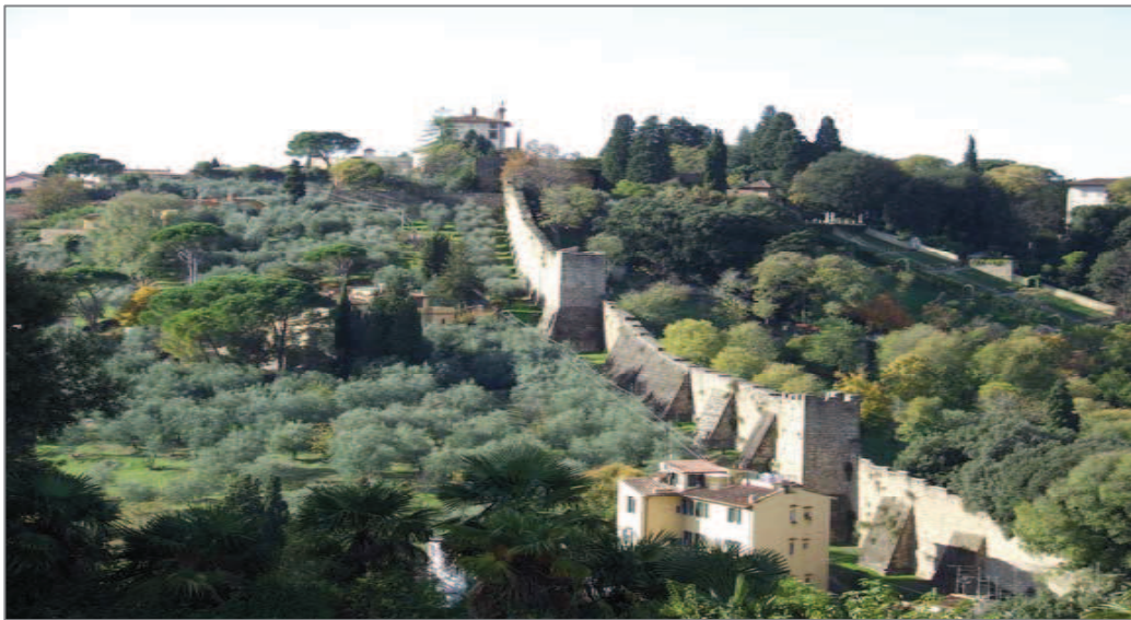
Il Forte e le mura visti dal Piazzale Michelangelo
