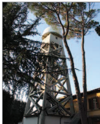
La torre solare
