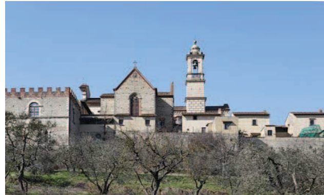
Veduta dal fronte stradale
