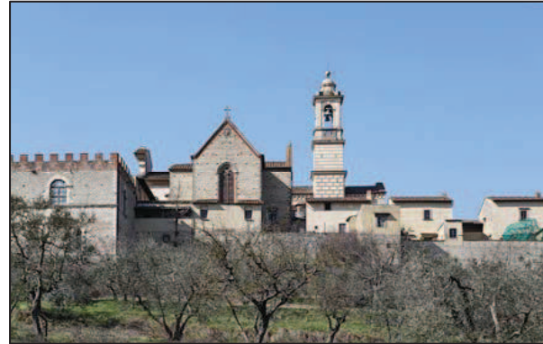
Veduta dal fronte stradale
