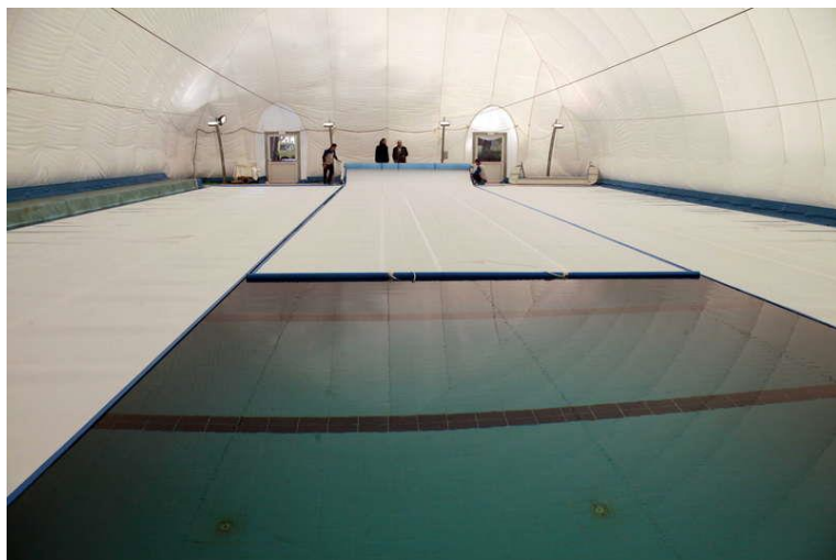
Teli isothermici a copertura delle vasche della piscina Costoli
